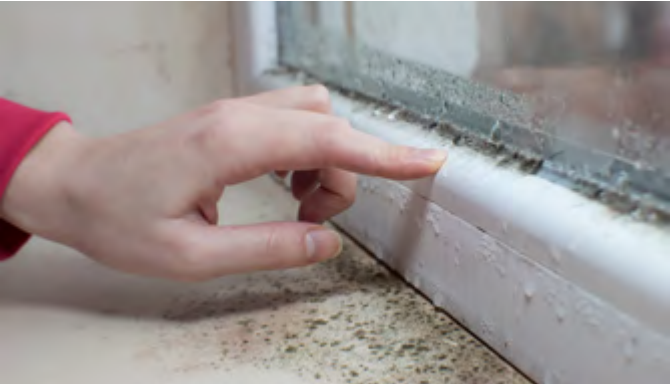
Fenstertausch bei der Sanierung – Isothermenverlauf, Luftwechselrate und Normen gehören in den Fokus
