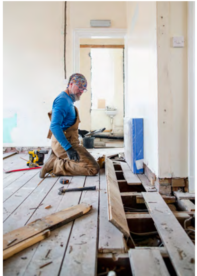
Neuer Bodenaufbau auf Holzbalkendecke
