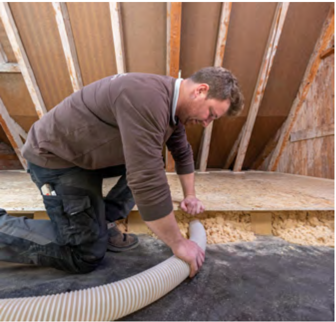
Begehbare Geschossdecke mit Holzfaserdämmung
