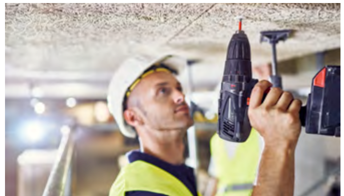
Nachträgliches Dämmen einer Kellerdecke mit Steinwolle und einer Holzwohle-Dämmplatte auf der Sichtseite
