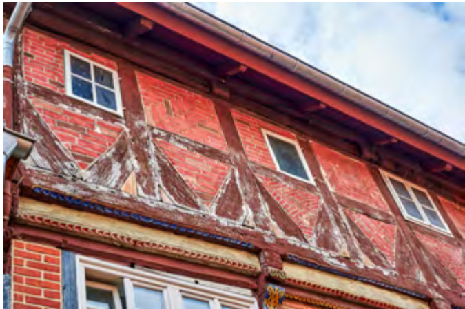
Die Fassade, ein Traum für den Fachwerkliebhaber, aber auch anspruchsvoll in der Sanierung
