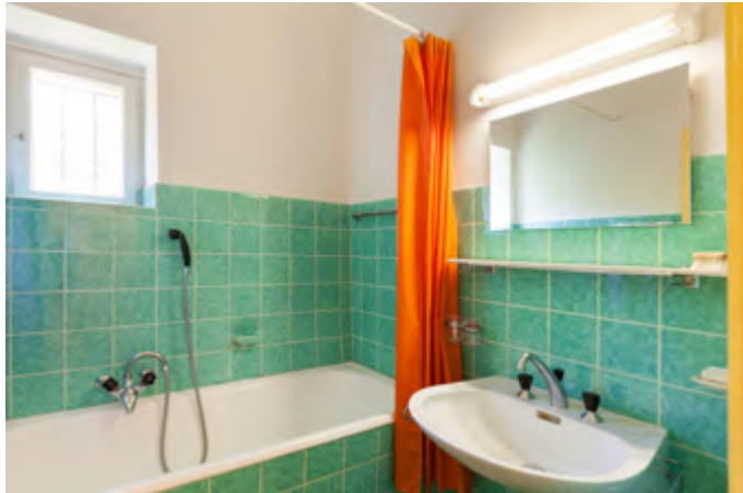
Ein Bad im Charme der 60er Jahre. Ist das Kult oder ein Sanierungsfall?
